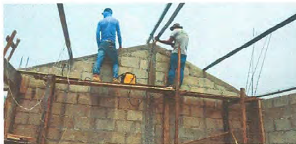
Foto 4: colocación de costanera
