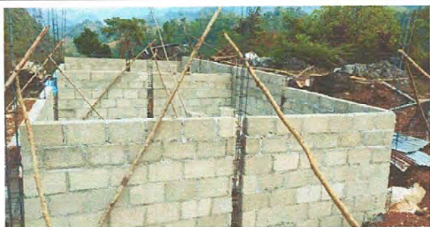
Foto 5: construcción de dos aulas
