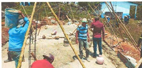
Foto 3: inicio de construcción
