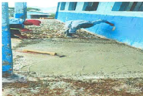
Foto 2: fundición de piso para corredor de aula
