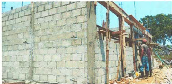
Foto1: fundición de solera
